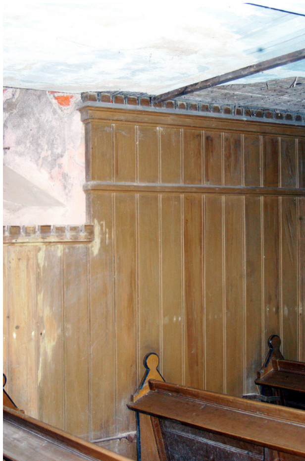
Wandpaneel unterhalb der Empore (Nordwand)
