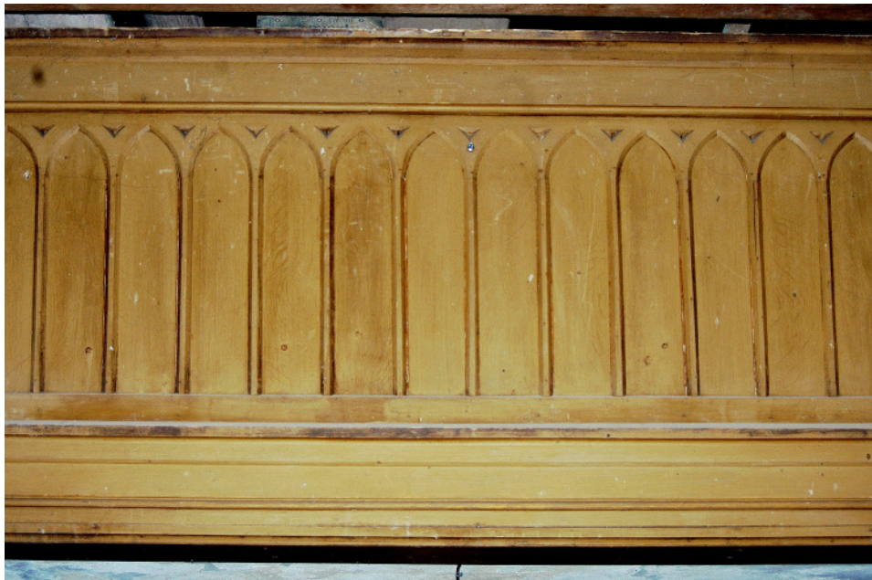
Ansicht der Emporenbrüstung
