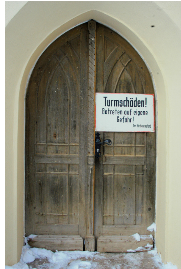
Haupteingangstür im Kirchturm
