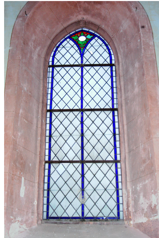
Seitliches Fenster mit einfacherer Verglasung
