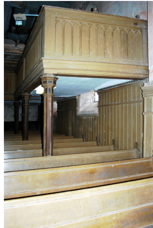
Hölzerne Empore (Nordseite)
