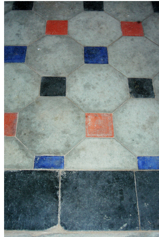
Fliesenboden im Altarraum (Zementfliesen)
