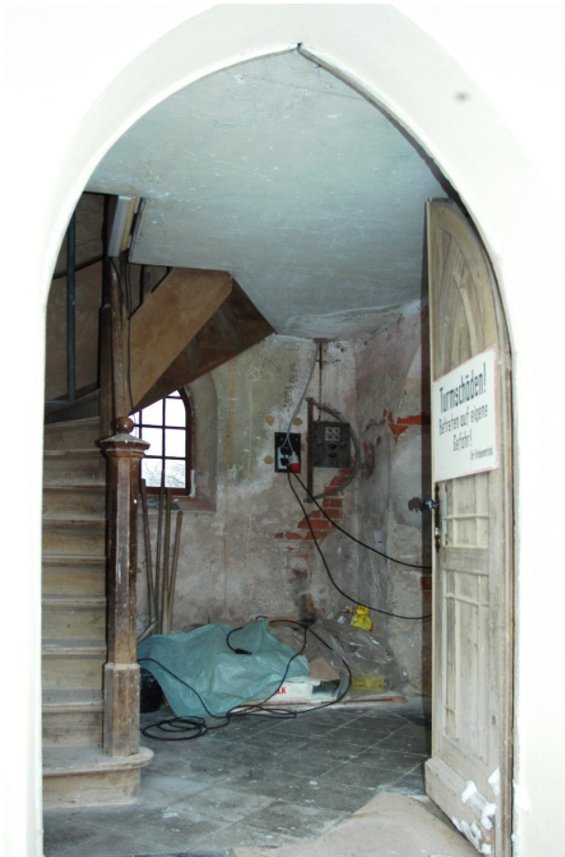
Blick in das „Treppenhaus“ des Kirchturms
