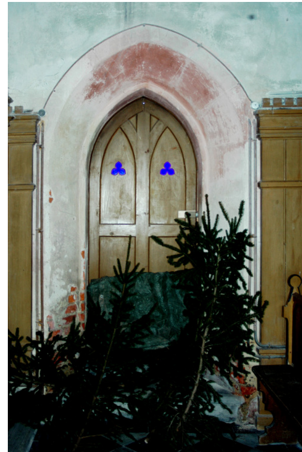
Tür vom Altarraum zur ehemaligen, heute abgerissenen Sakristei
