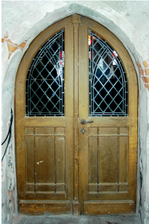
Tür vom Vorraum (Turm) zum Kirchenraum
