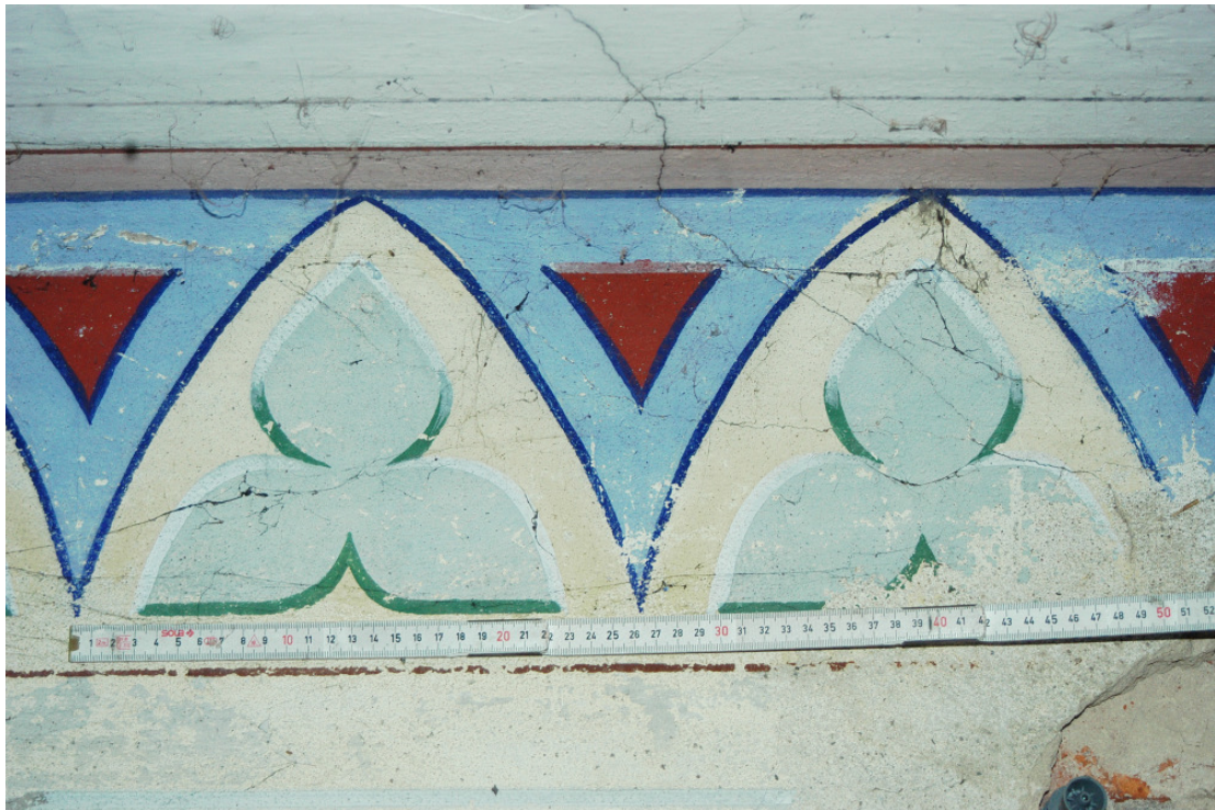
Der Zierfries innerhalb der Deckenkehle im Detail.
