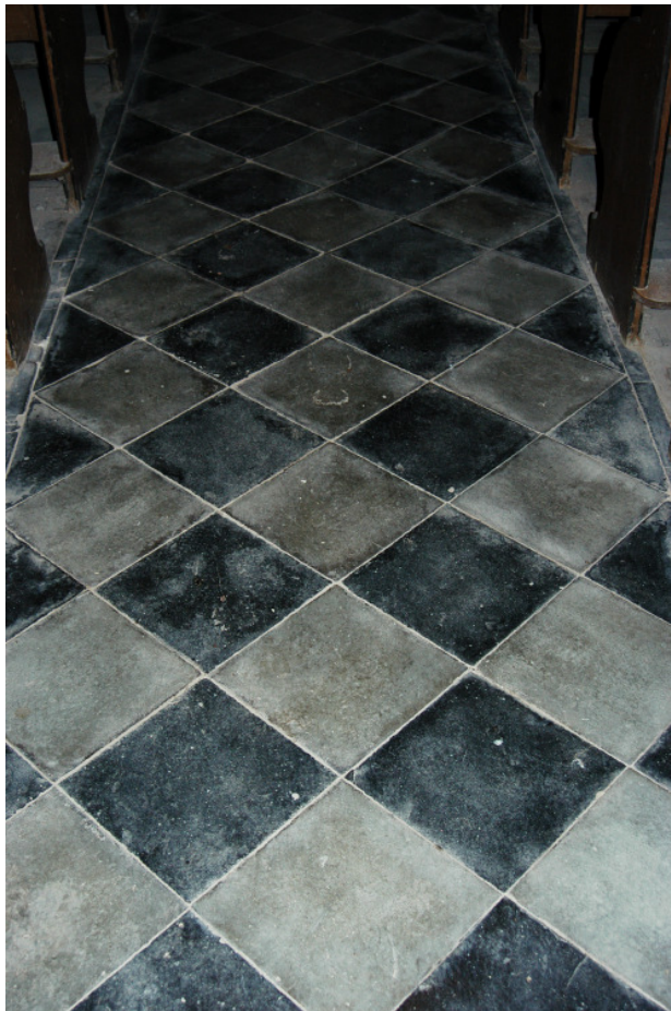
Fliesenboden im Kirchenschiff (Zementfliesen)
